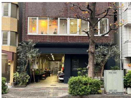
バナナ倉庫ビル全体をリノベーション 弊社事務所2F
